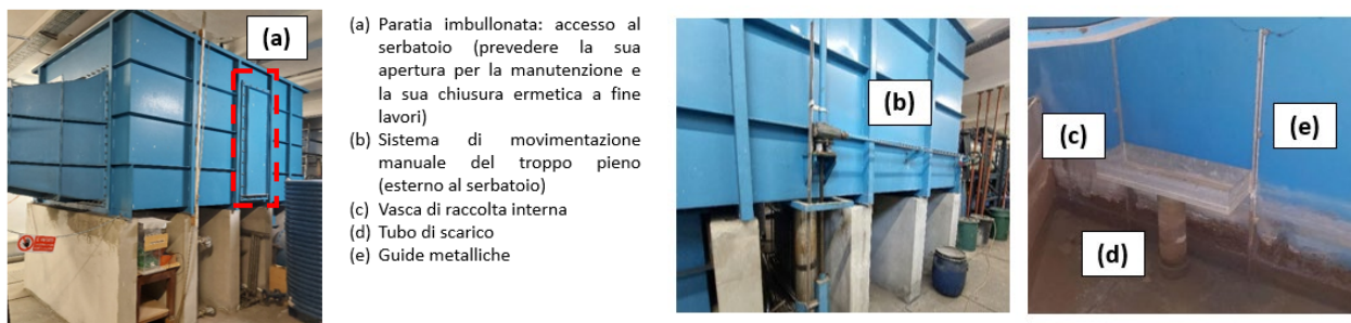
Figura C.1.1 ingresso del serbatoio e troppo pieno
