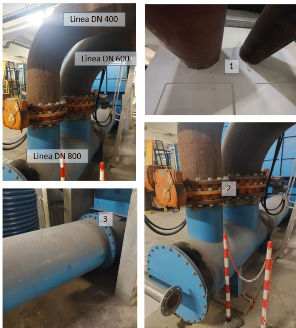
Figura A.3.1 linee di alimentazione DN400, DN600 e DN800
