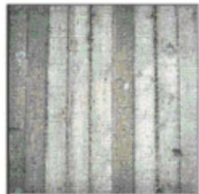
Figura 9 - Variazioni di colore sulla superficie in evidenza poche ore dopo la rimozione delle casseforme
