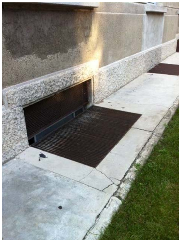
Fig. 14 – dettaglio della pavimentazione e di griglia esistente posta sulla bocca di lupo
