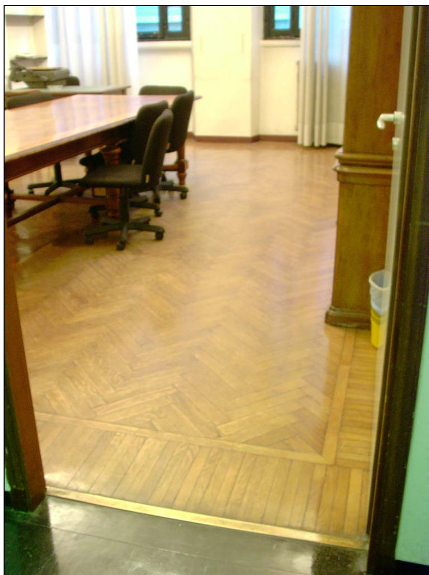
fig. 8 – Parquet di rovere posato a sina di pesce con fascia e bindello in un ufficio a piano rialzato
