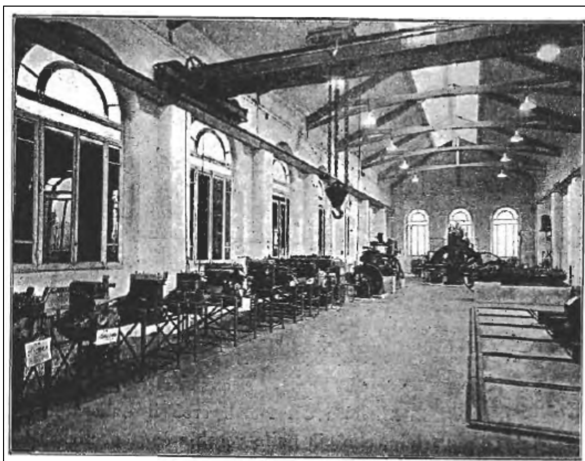
fig. 5 – Il capannone nella configurazione originaria con le capriate “a vista”
