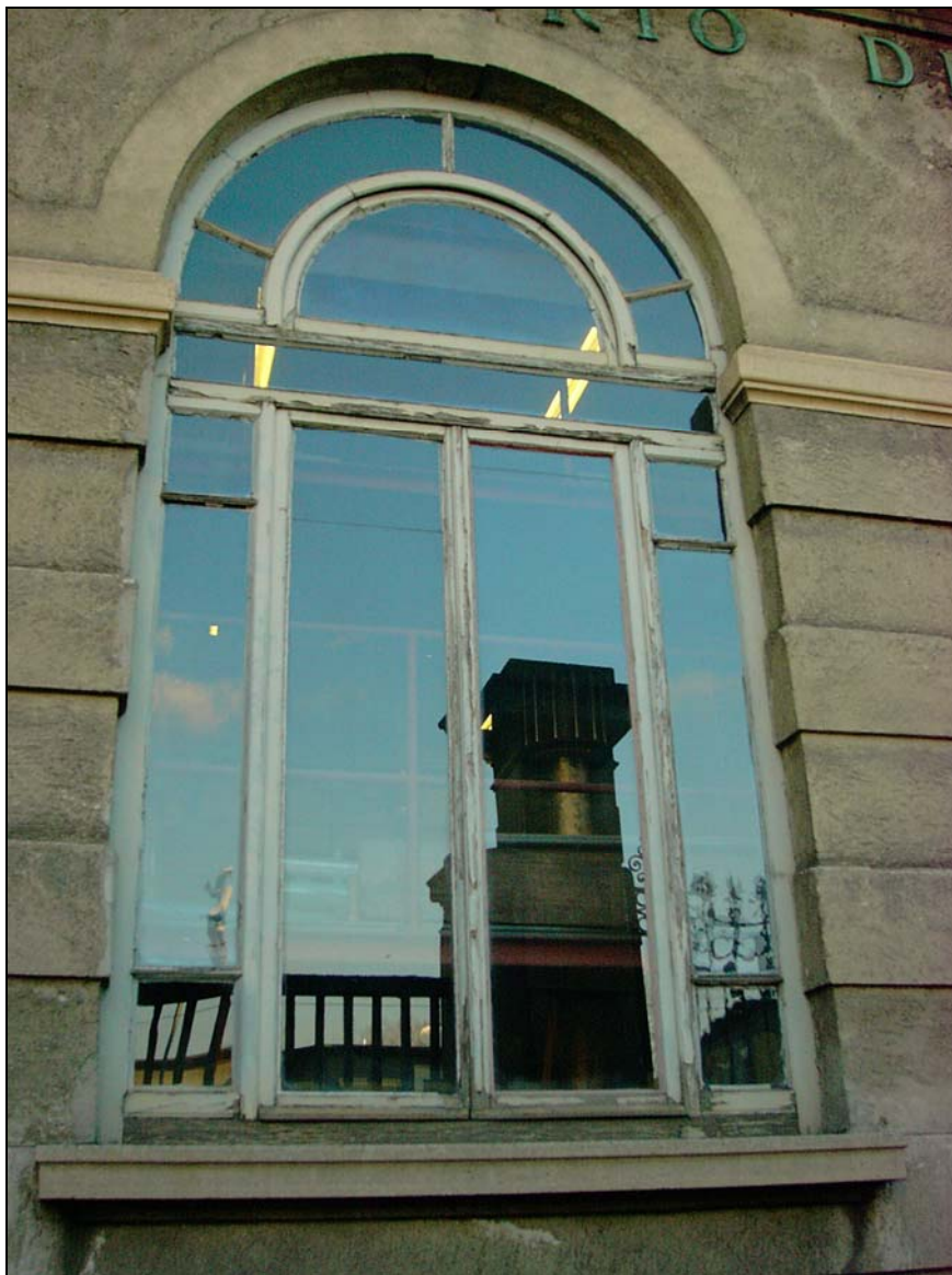
fig. 13 – Le condizioni fatiscenti di un serramento esterno
