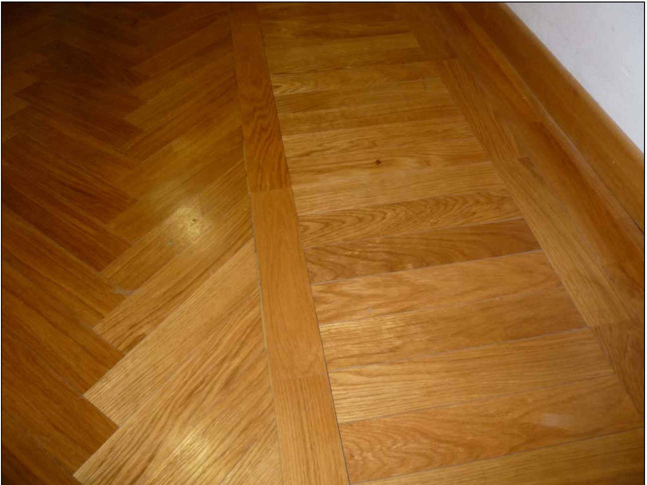
fig. 32 – Esempio di pavimentazione in parquet di rovere posata a spina di pesce con fascia e bindello
