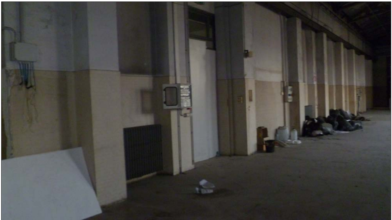
fig. 28 – Le portefinestre tamponate lungo il lato sud del capannone
