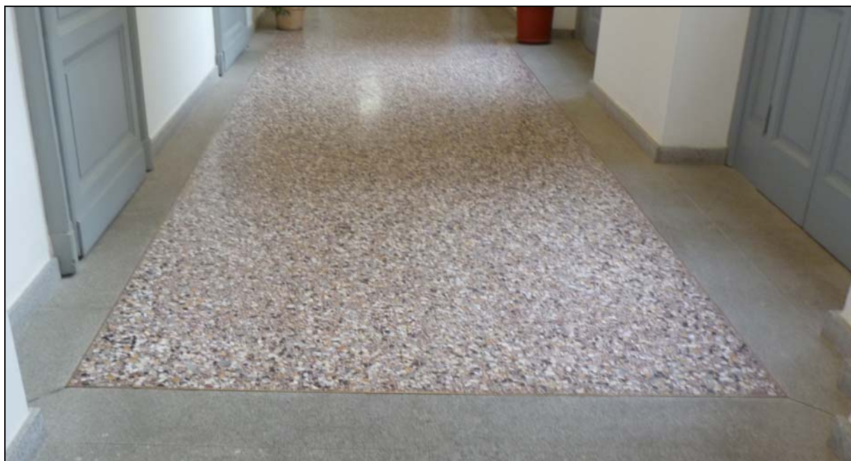
fig. 32 – Esempio di pavimentazione in seminato alla veneziana
