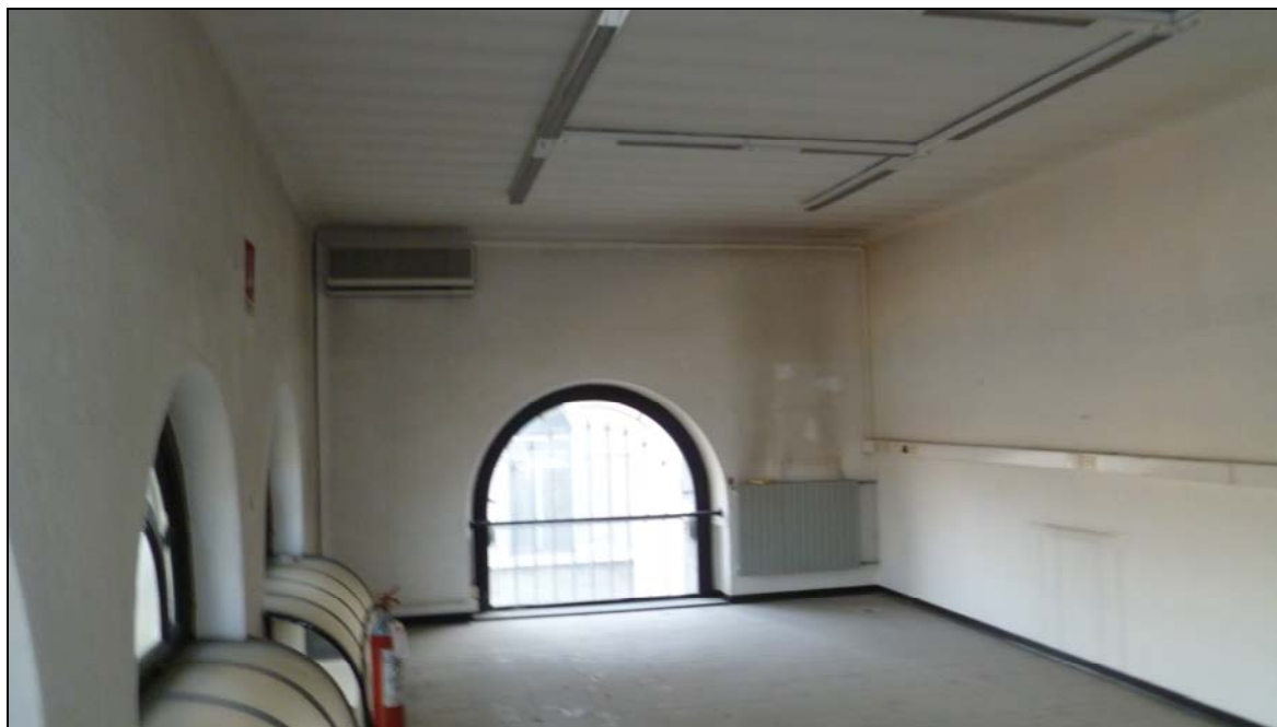
fig. 29 – Le portefinestre tamponate lungo il lato sud del capannone
