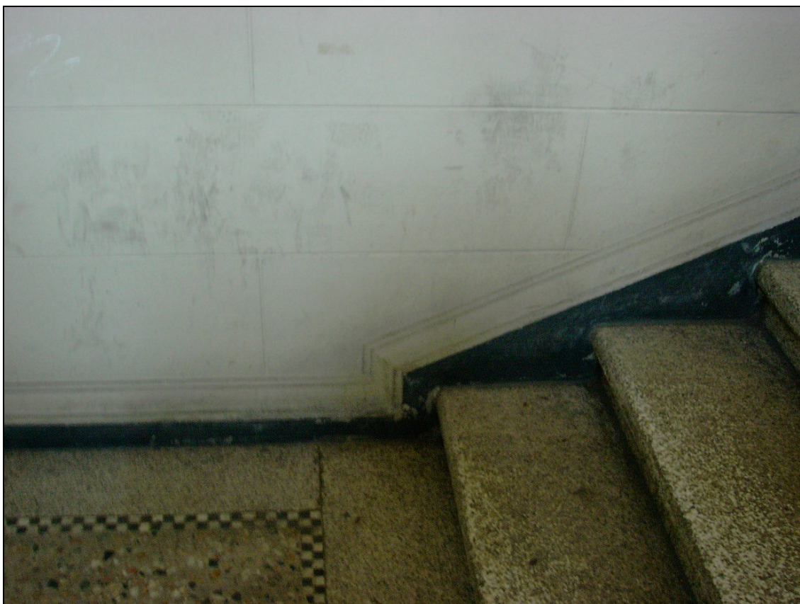
fig. 6 – Lo scalone originario con i gradini in granito e il pavimento “alla veneziana”
