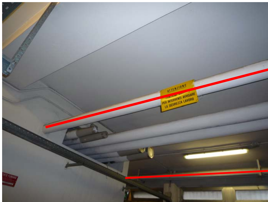
Foto 06 – Piano Seminterrato – Tubazioni coibentate con amianto.
