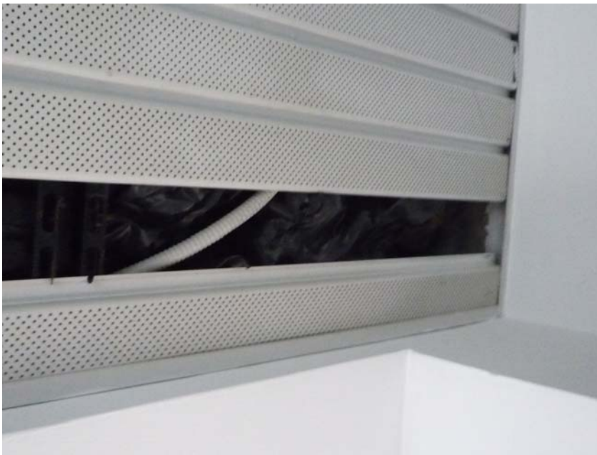
Foto 03 – Controsoffitto in doghe con lana minerale imbustata.
