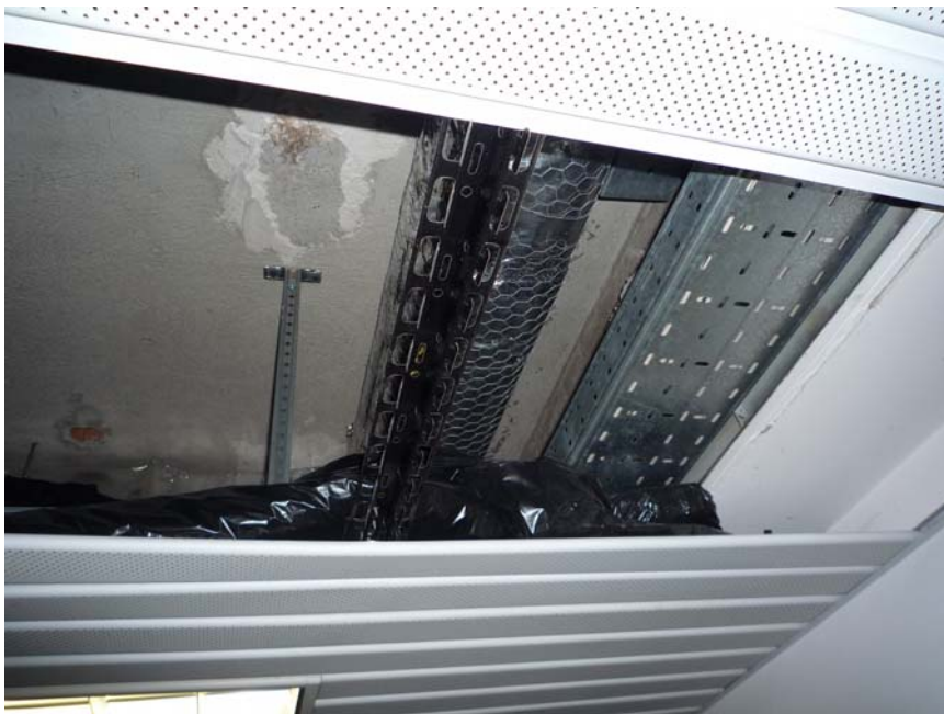
Foto 04 – Controsoffitto in doghe con lana minerale imbustata.
