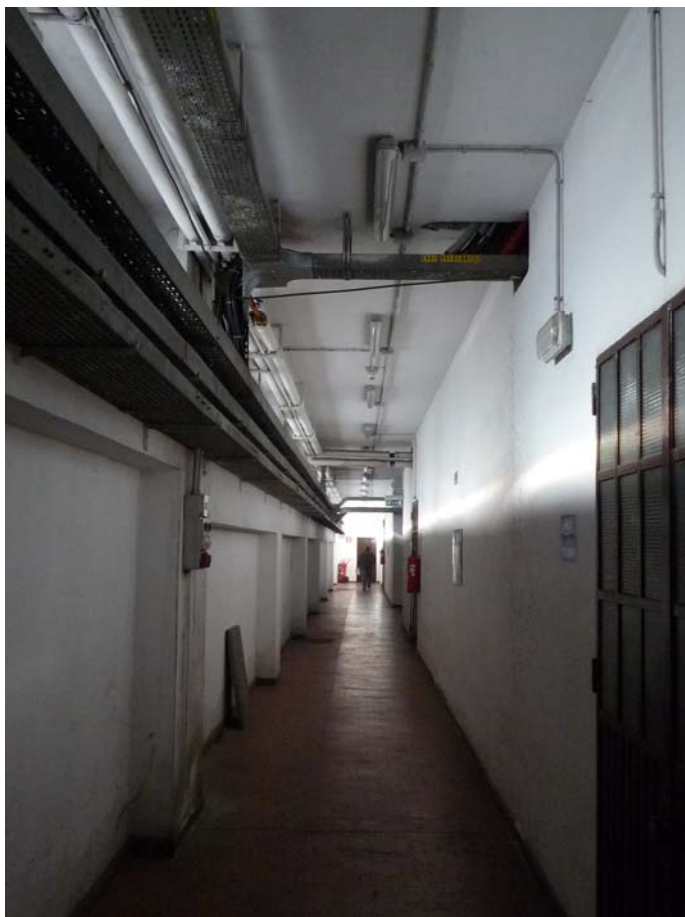
Foto 05 – Piano Seminterrato – Tubazione coibentate con amianto.
