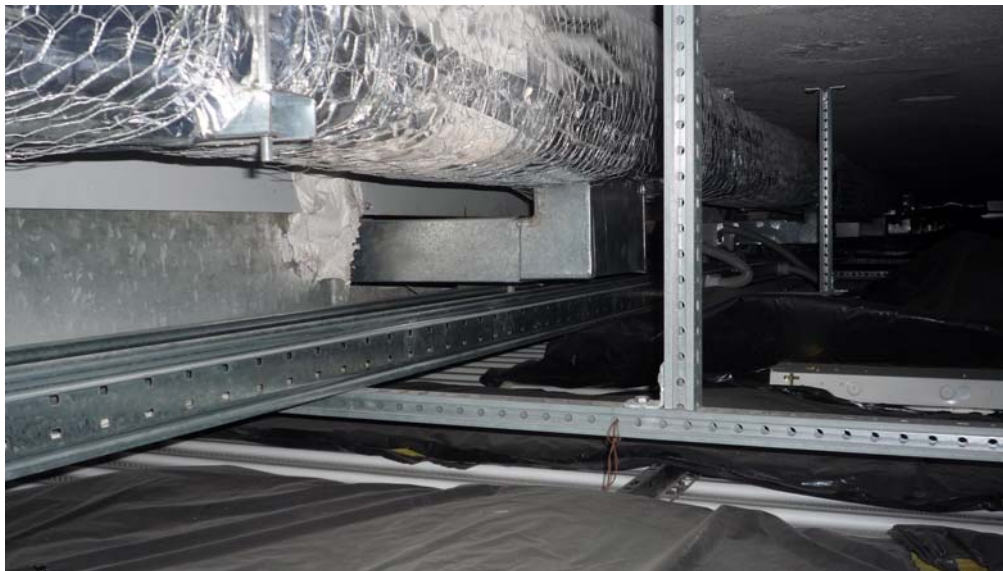
Fig.15 – Controsoffitto in doghe metalliche: passaggio impianti e coibentazione
