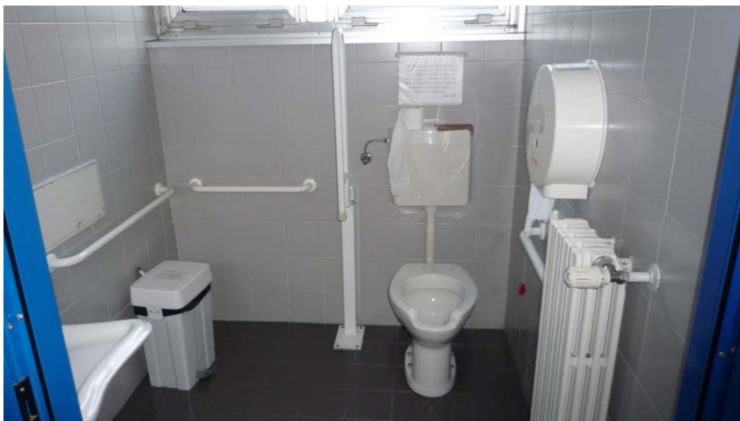
Fig.11 – Pavimento e rivestimento in gres nei bagni ristrutturati di recente – w.c. disabili, ala est
