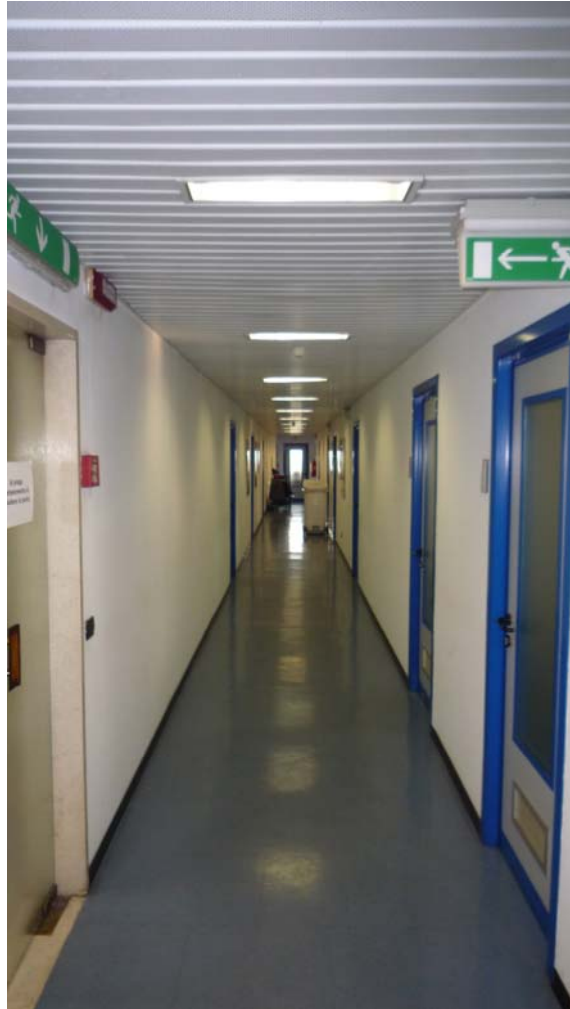
Fig.14 – Controsoffitto in doghe metalliche
