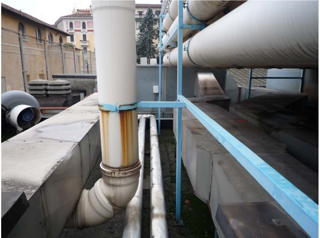
Fotografia 7): Vista di tubazione di espulsione cappa 1 e particolare struttura di supporto tubazioni.
