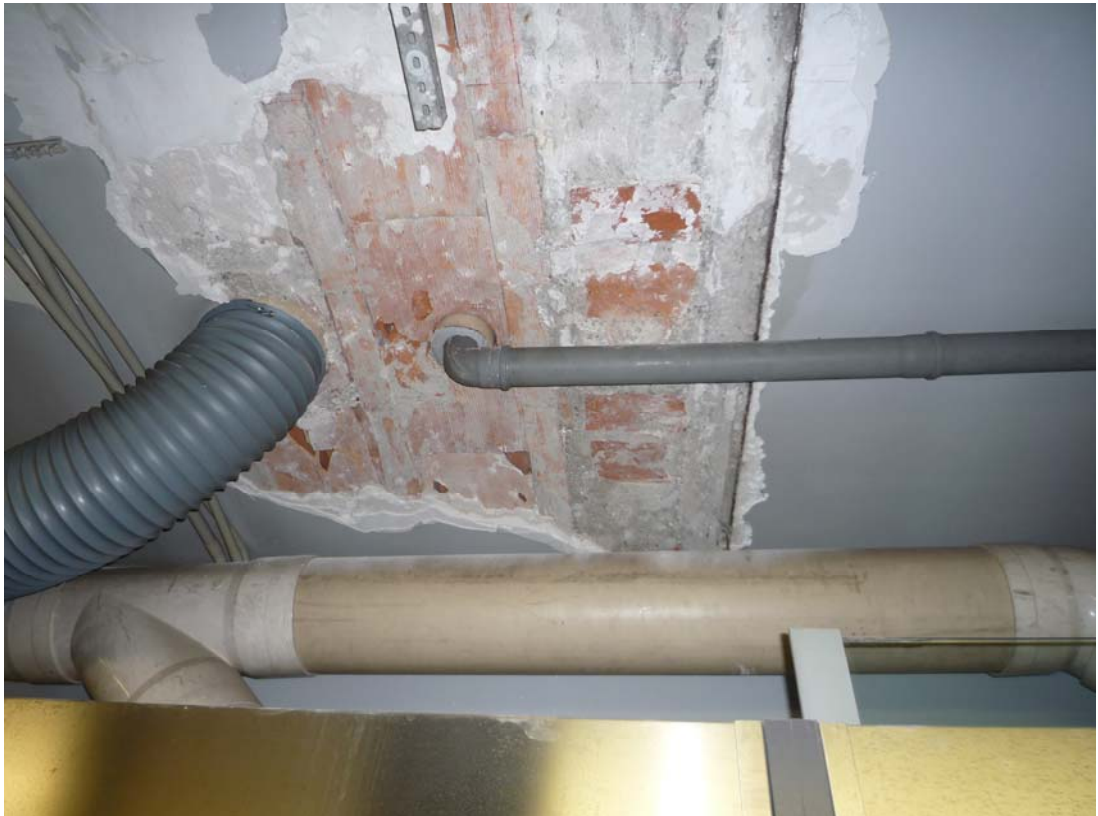
Fotografia 6): Imbocco delle tubazioni di collegamento tra le cappe ed i ventilatori ed effetti delle infiltrazioni sull'intonaco sottostante.
