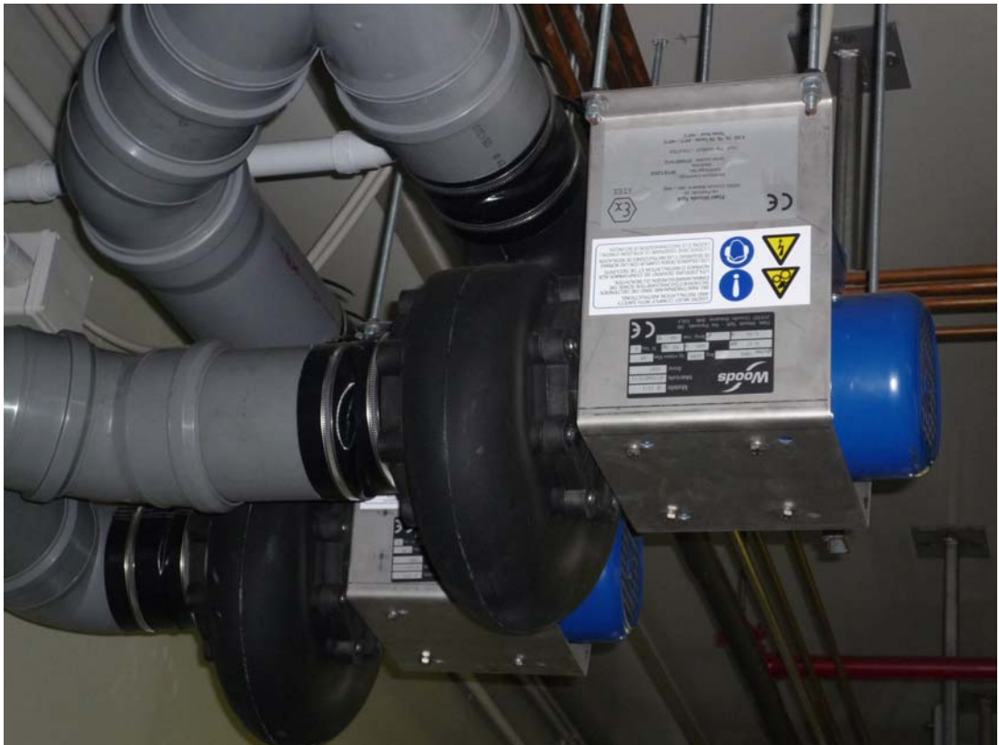
Foto. 5): Ventilatori d'estrazione centrifughi gemellari in ambiente previsti per l'aspirazione degli armadi.
