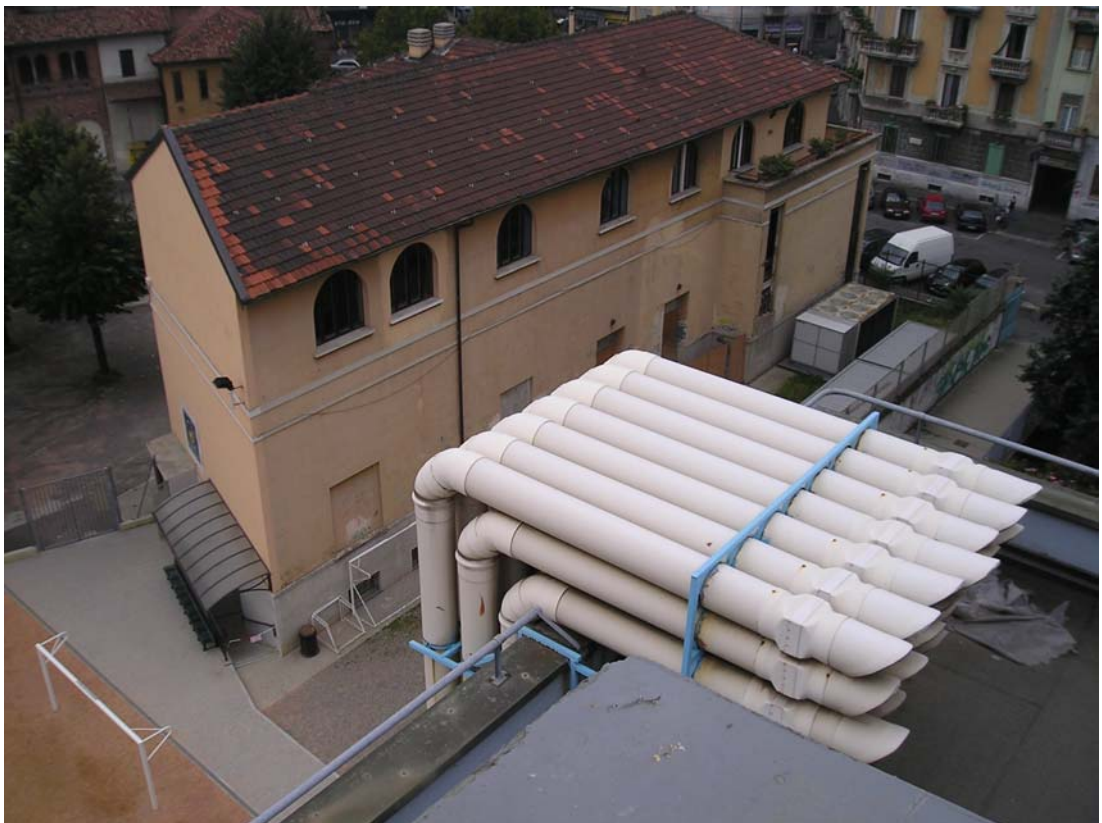
Fotografia 10): Vista del castello di supporto e del tratto d'espulsione sulla copertura dell'ed. 4.
