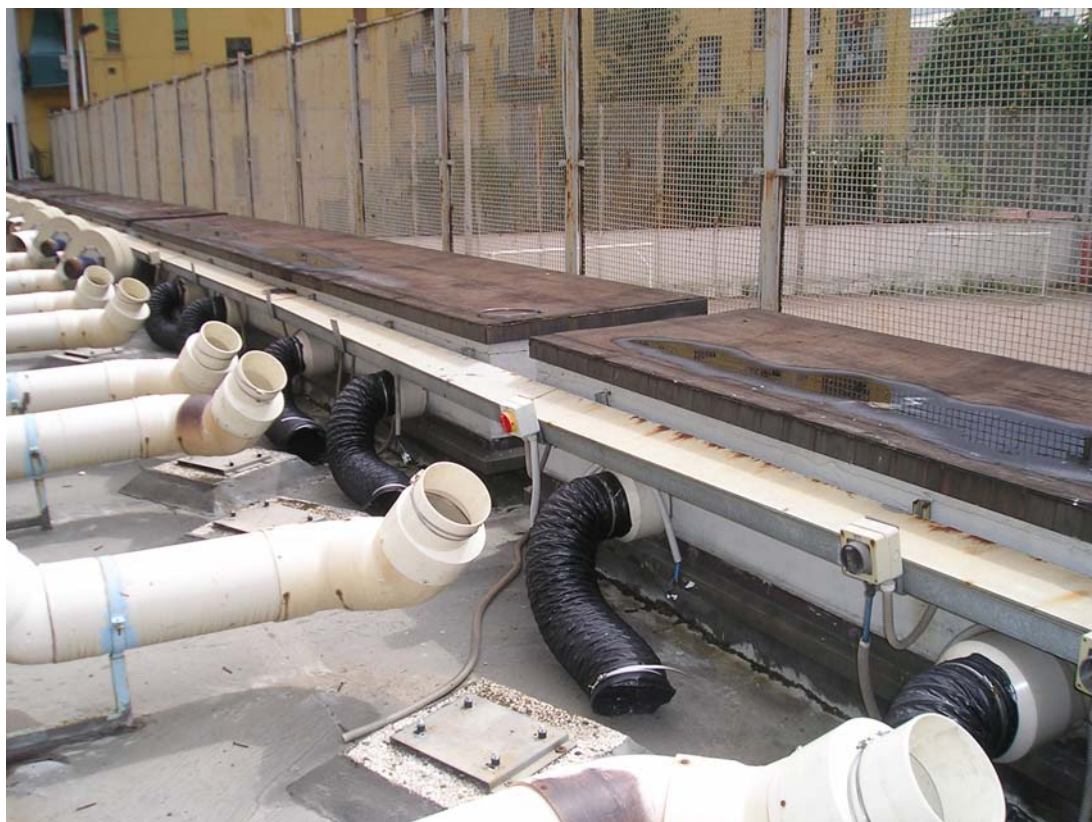
Fotografia 2): Vista della sede dei ventilatori e dell'attacco delle tubazioni flessibili ai cassonetti delle tubazioni di collegamento cappe-ventilatori a cui è fissato il canale porta linee di alimentazione.
