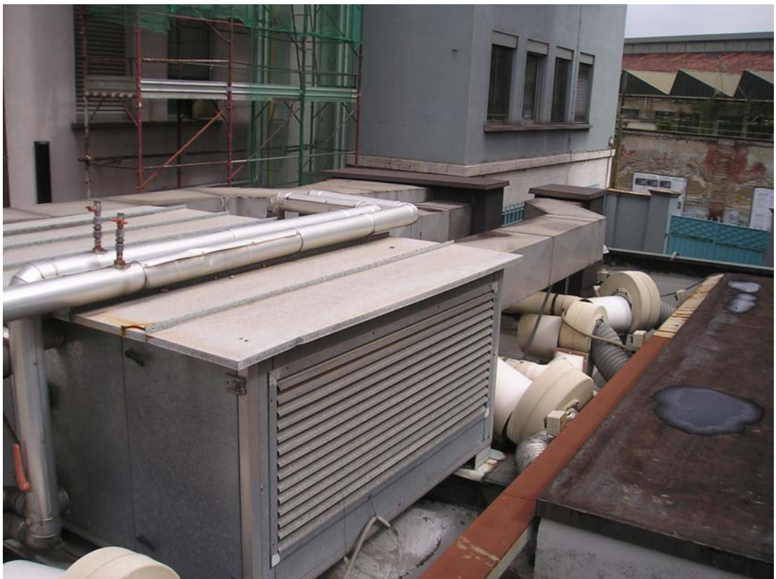
Fotografia 4): Vista dell'Unità Trattamento Aria (UTA-2) e dei canali aeraulici sul lato EST.
