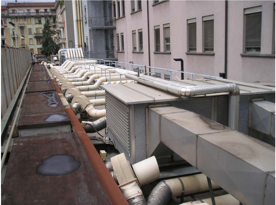
Fotografia 3): Vista dei cassonetti di chiusura delle tubazioni di collegamento cappe-ventilatori, della linea gas, della recinzione in rete metallica di contenimento del campo sportivo in confine e della UTA 2.
