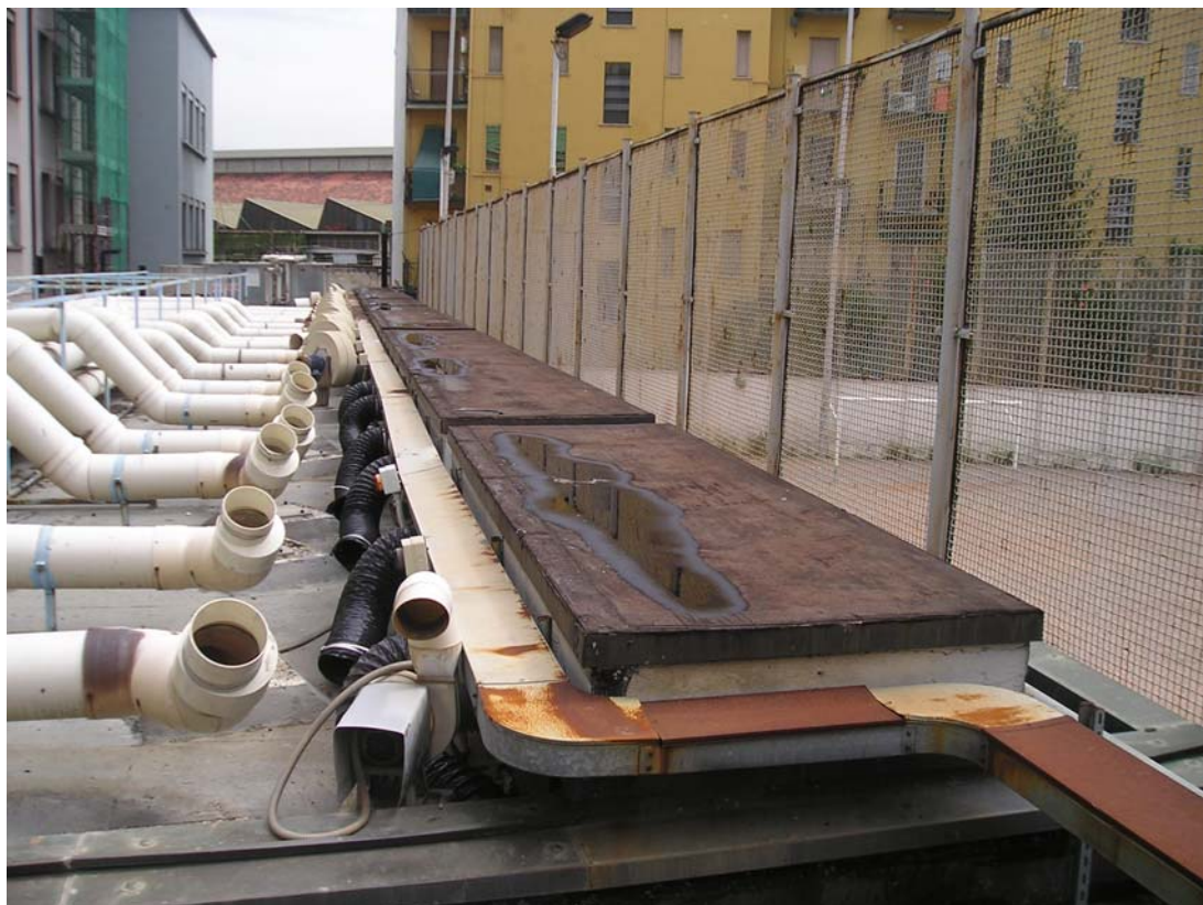
Fotografia 1): Vista dei cassonetti in muratura di chiusura tubazioni di collegamento cappe-ventilatori e della recinzione in rete metallica di contenimento del campo sportivo in confine
