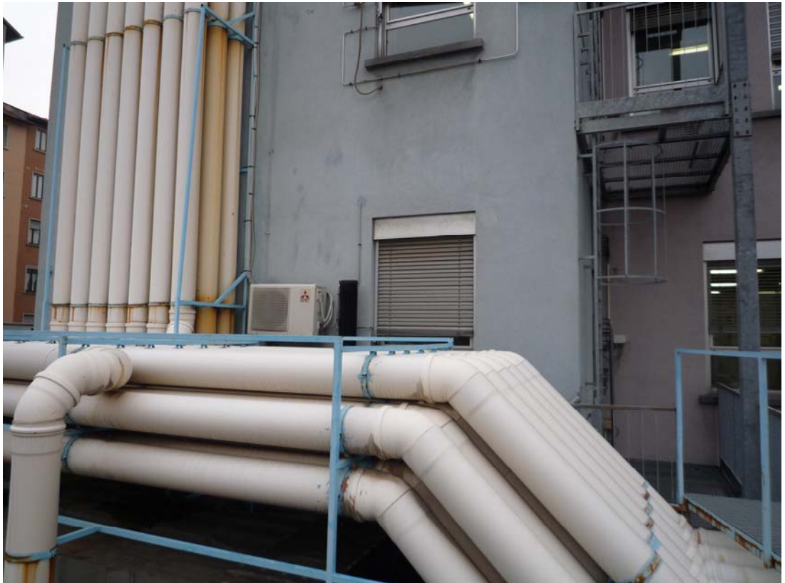
Fotografia 8): Vista del castello di supporto e fascio di tubazioni per espulsione in aderenza all'ed. 4.
