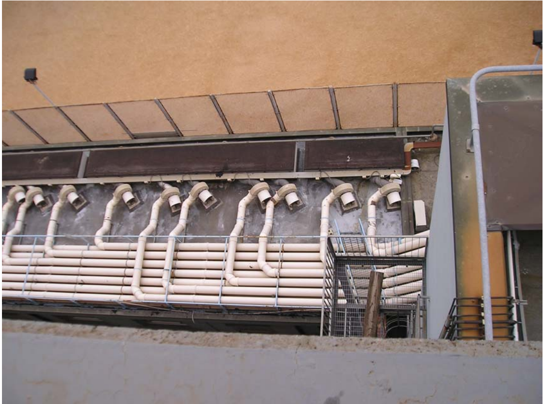
Fotografia 9): Vista dall'alto della copertura con i ventilatori ed il fascio di tubazioni per l'espulsione.
