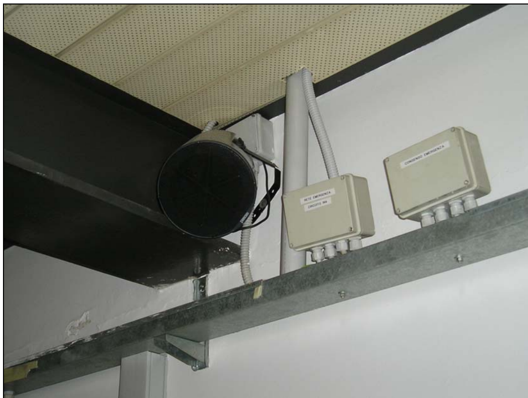
Scatole di derivazione su passerella metallica
